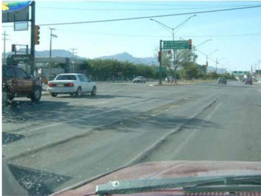
**e)Roderas.** Son deformaciones del perfil transversal por hundimiento a lo largo de las rodadas, con la aparición de cordones laterales a cada lado de la rodera. La profundidad máxima de la rodera, se mide con una regla colocada transversalmente al eje de la carpeta a cada 100 m. o más.
