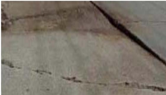
La posible causa es debida a la expulsión de los finos de la capa inferior hacia la superficie por el fenómeno conocido como bombeo de materiales, que se da porque la capa inferior se satura de agua.
