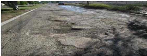
Huecos o Baches Abiertos. Cavidades o depresiones producidas por desprendimiento de la carpeta asfáltica y de capas granulares.
