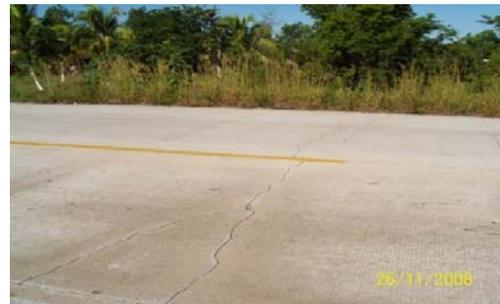
La posible causa puede ser la excesiva repetición de cargas pesadas (fatiga), deficiente apoyo de las losas, asentamientos de las capas inferiores, excesiva relación longitud / ancho de la losa o deficiencias en la construcción de éstas. La ausencia de juntas transversales, conducen a fisuras normales al eje o diagonales, regularmente distribuidas o próximas al centro de las losas, respectivamente. Variaciones significativas en el espesor de las losas provocan también fisuras.
