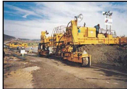
***Tendido de concreto hidráulico con cimbra deslizante***
