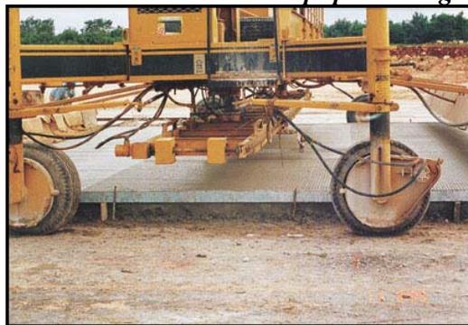
*Colocación y vibrado del concreto*
