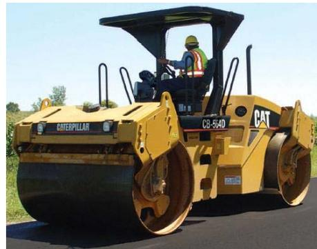
***Tendido y conformación de carpeta asfáltica***
